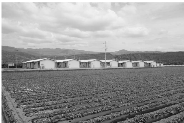
(写真) 西原村小森第1仮設住宅（木造仮設住宅）
