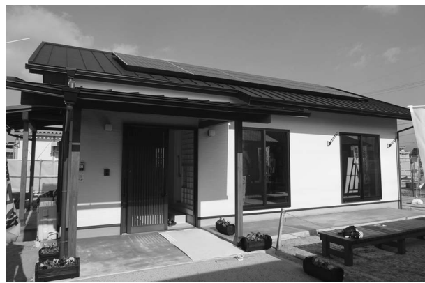
(写真) 2号棟の外観 建築士会・くまもと復興の家グループ
