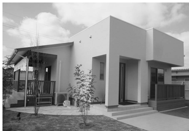
(写真) 1号棟の外観 KKN（熊本工務店ネットワーク）
