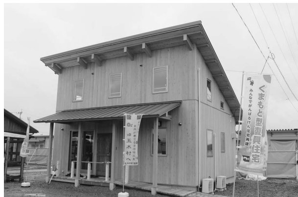
(写真) 3号棟の外観 五木源住宅復興支援チーム
