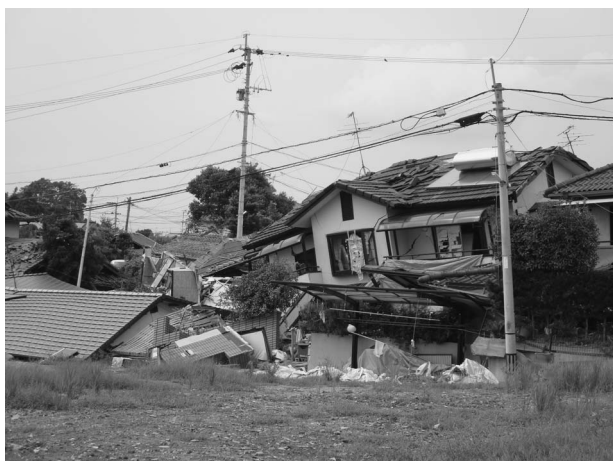
(写真) 益城町の被災状況
