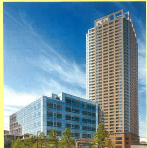
【建替後の外観】
