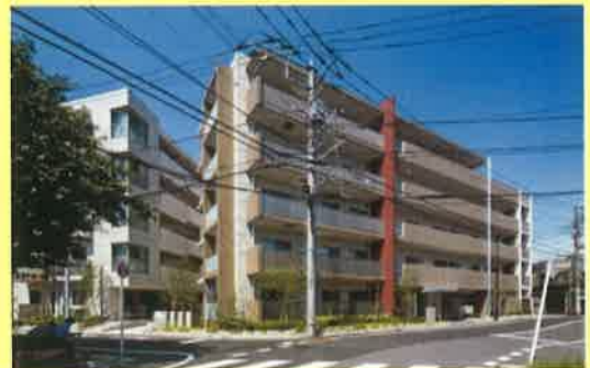
【建替後の外観】
